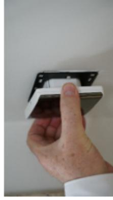
3. Conectar cableado al termostato 4. Colocar termostato sobre la base
