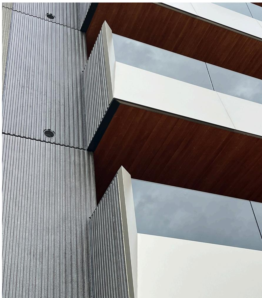
Boca exterior recuperador de calor
